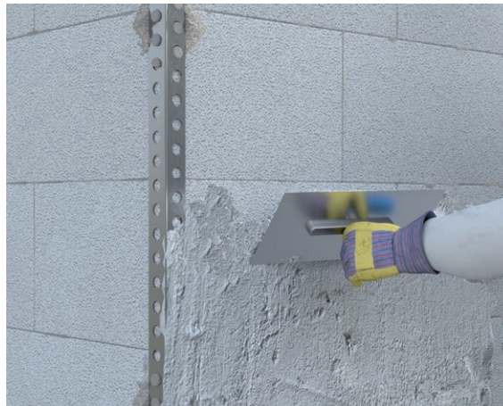
Abb. 2.1: Einlagiger Leichtputz als Außenputz auf Porenbetonmauerwerk – manuelles Aufbringen der ersten Schicht
