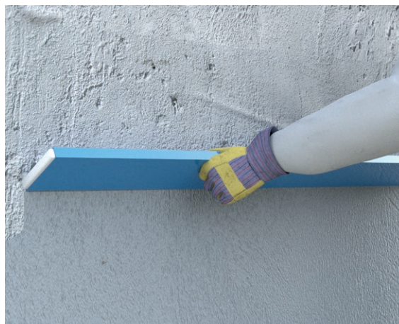
Abb. 2.2: Einlagiger Leichtputz als Außenputz auf Porenbetonmauerwerk – planebenes Abziehen mit einem Richtscheit
