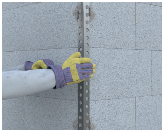
Abb. 1.7: Sicherung der senkrechten Gebäudekanten durch Eckschutzprofile
